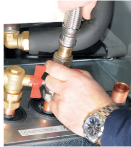
1. Lossa kylmodulens elkabelkontakt och slangar.
