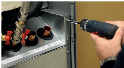
3. Avlägsna kylmodulens fästskruvar.
