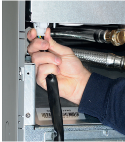
1. Lossa kylmodulens elkabelkontakt och slangar.
